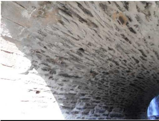
Ouvrage d'art avec cavités artificielles et fissures laissées en place (fissures qui ne présentent pas d'enjeux structurels pour l'ouvrage)
