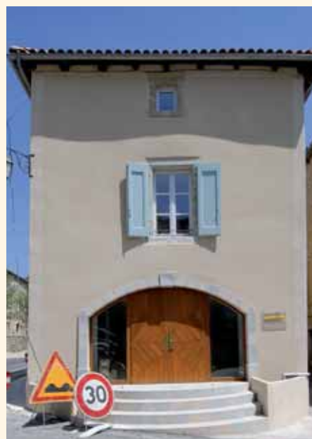
L'ancien presbytère rénové accueille le siège de la communauté de communes.
