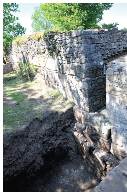
Vue du mur antique et du fossé médiéval de Bozouls (cl. Conseil général, SDA)
