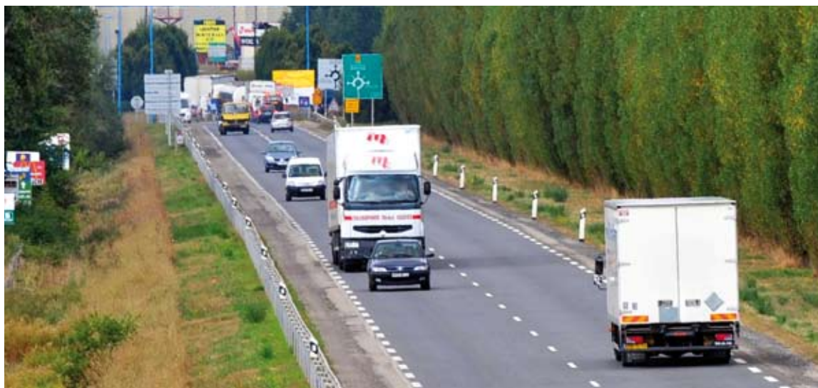
La RN 88 actuelle est inadaptée à une circulation croissante
