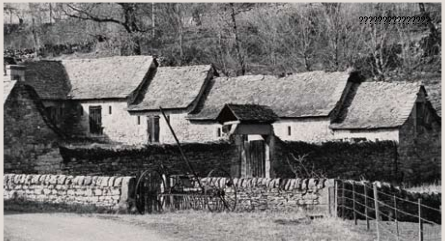
Une partie des Bourines : les porcheries avant que les toitures ne s'effondrent
