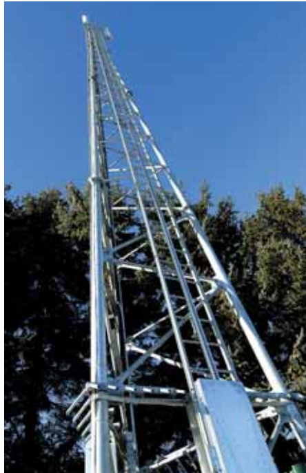
Un pylône de téléphonie mobile opérationnel pour l'ensemble des habitants du canton et même au-delà.
