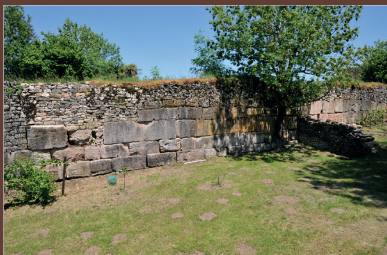
Vue générale du mur antique
