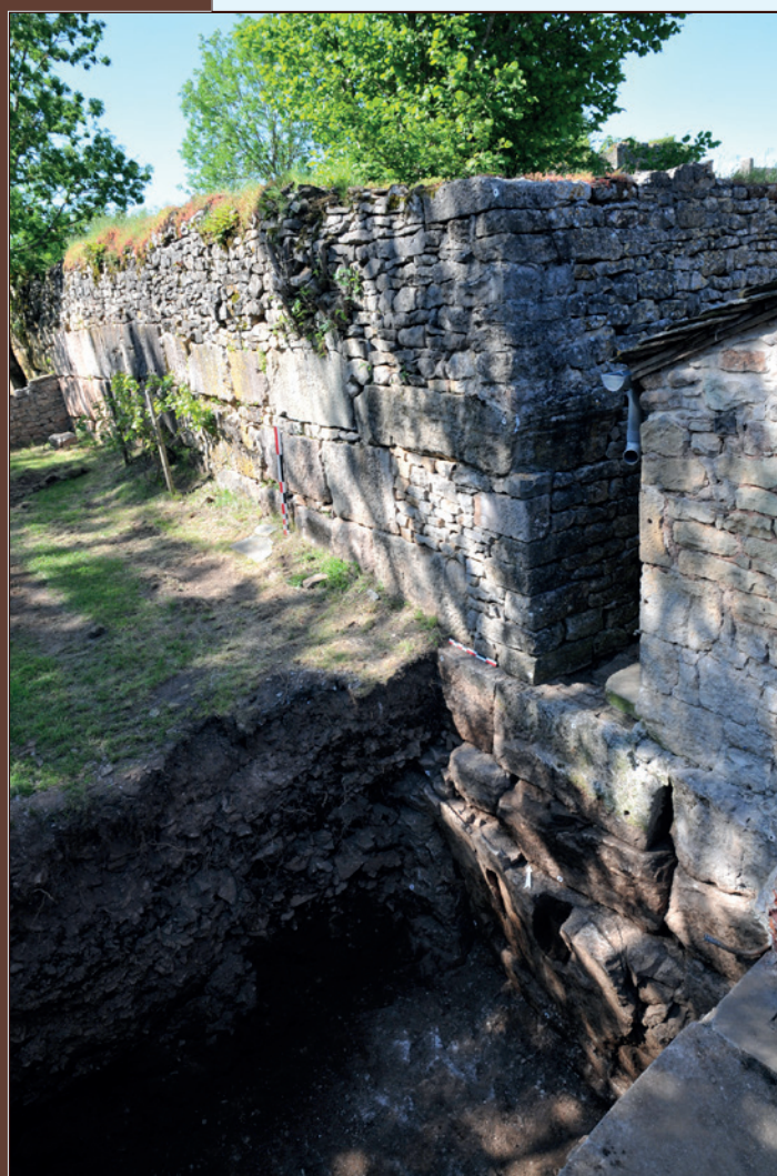
Articulation du fossé médiéval et du mur antique
