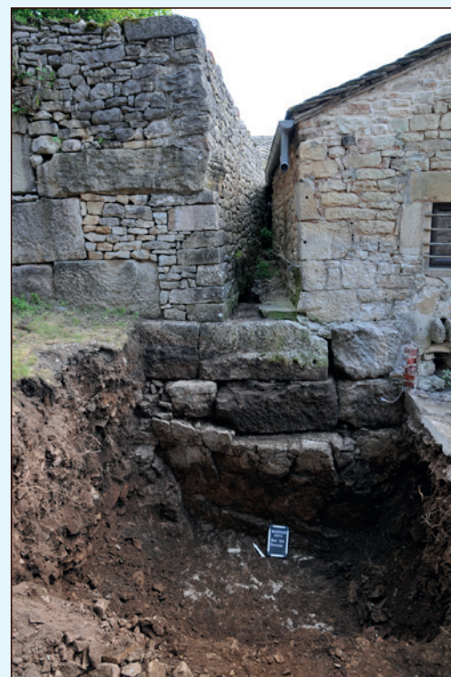
Détail du fossé médiéval et de la semelle de fondation du mur antique
