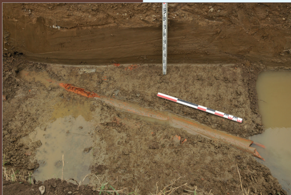
Vue de la canalisation antique
