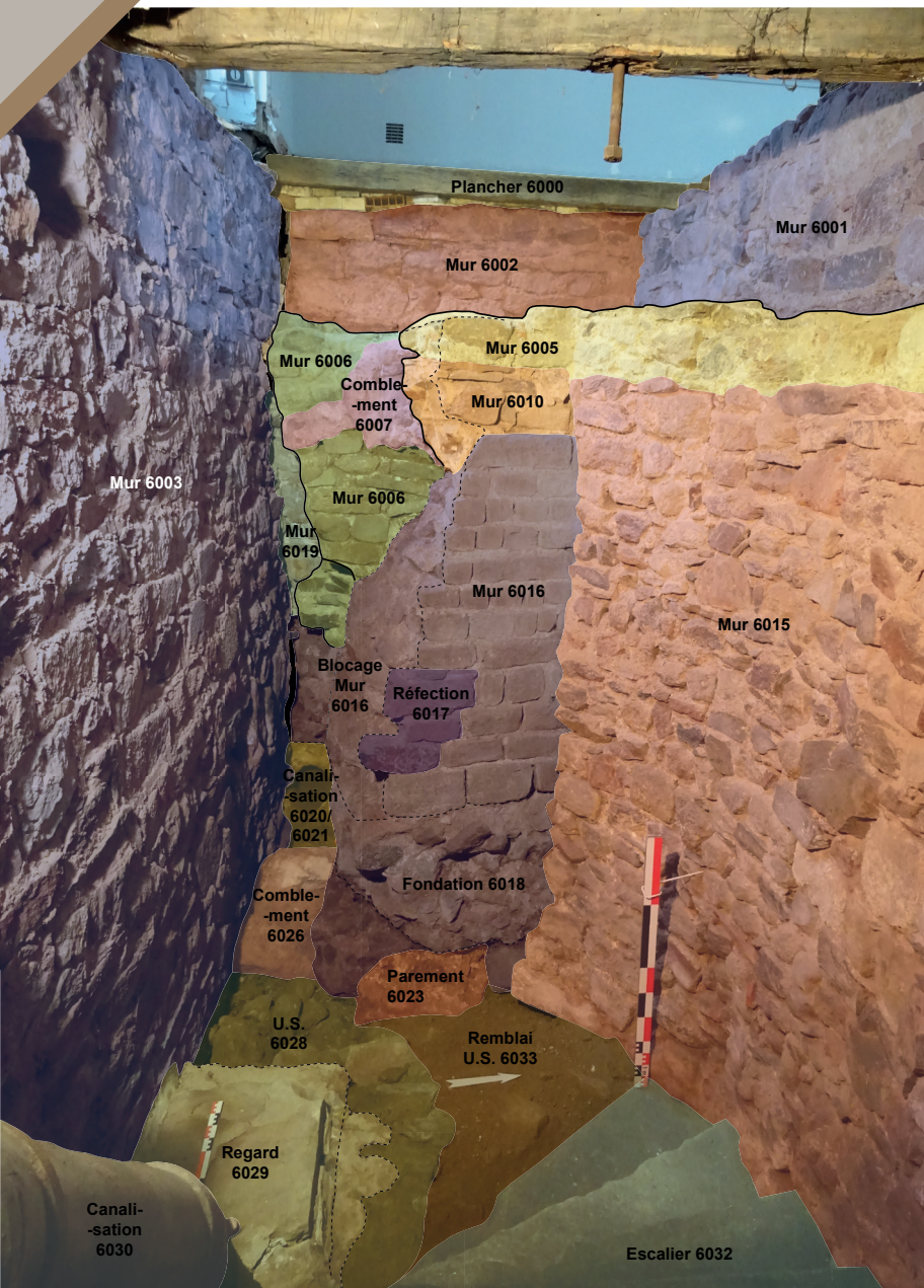
4: Rodez, palais épiscopal. Vue des maçonneries du secteur 6, dont le probable rempart antique 6016 (© et DAO J. Trescarte, SDA 12).
