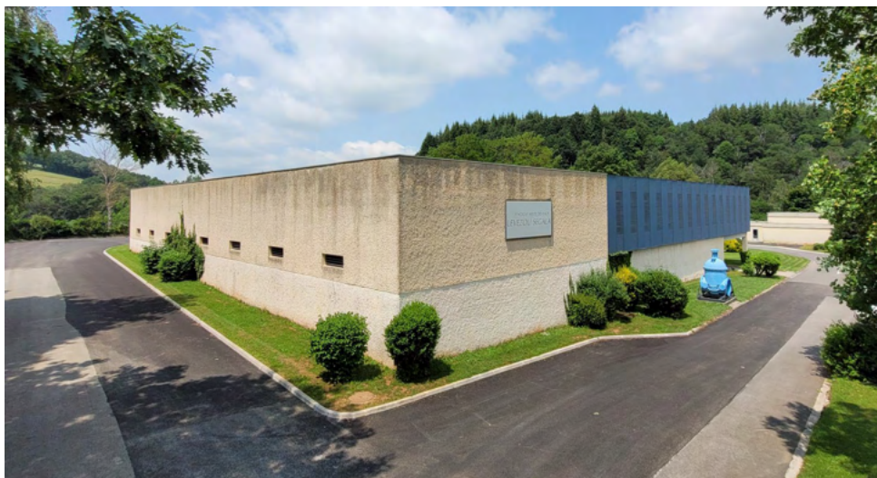
Figure 2 : usine de production d'eau potable du Moulin de Galat - capacité de traitement de 45 000 m 3 /j Crédit photo : Syndicat Mixte des Eaux Lévézou Segala
