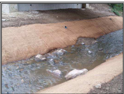
Seuil de calage en vue de stabiliser le profil et long et de diversifier les écoulements
