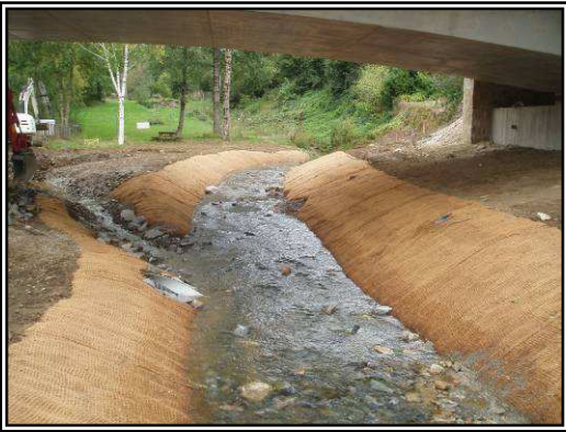
Recharges et apports gravelaires du fond du cours d'eau
