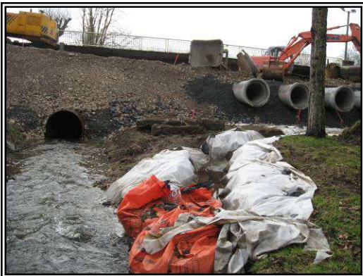
Mise en place d'un batardeau pour la bonne réalisation des travaux
