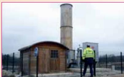
Au Burgas (Ste Radegonde), un système innovant permet d'éviter les mauvaises odeurs par combustion des biogaz.
