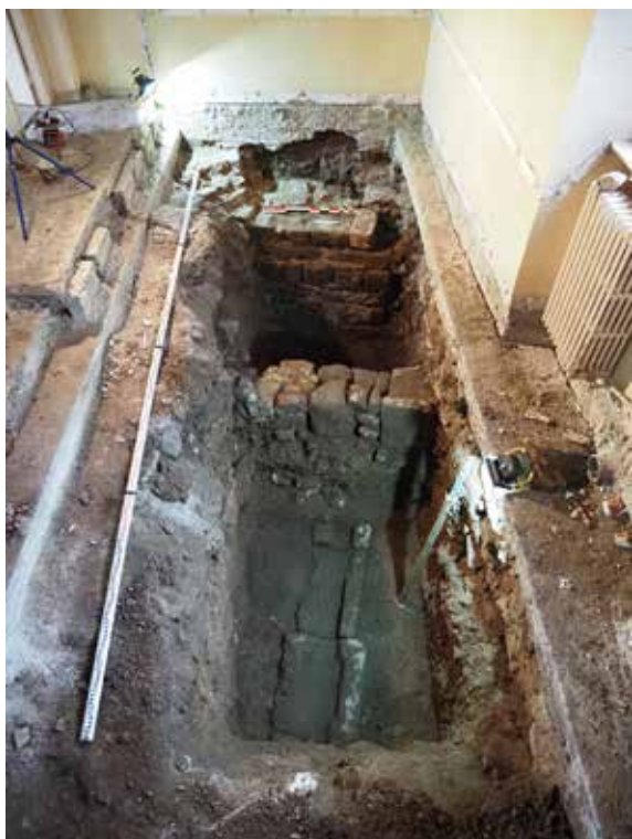
Vue générale de la tranchée 8 réalisée lors du diagnostic d'archéologie préventive de l'aile Frayssinous au Palais épiscopal de Rodez. Au premier plan : canalisation gallo-romaine, au milieu : mur mérovingien (V e -VIII e s.), à l'arrière-plan : mur médiéval (XI e -XIII e s.).
