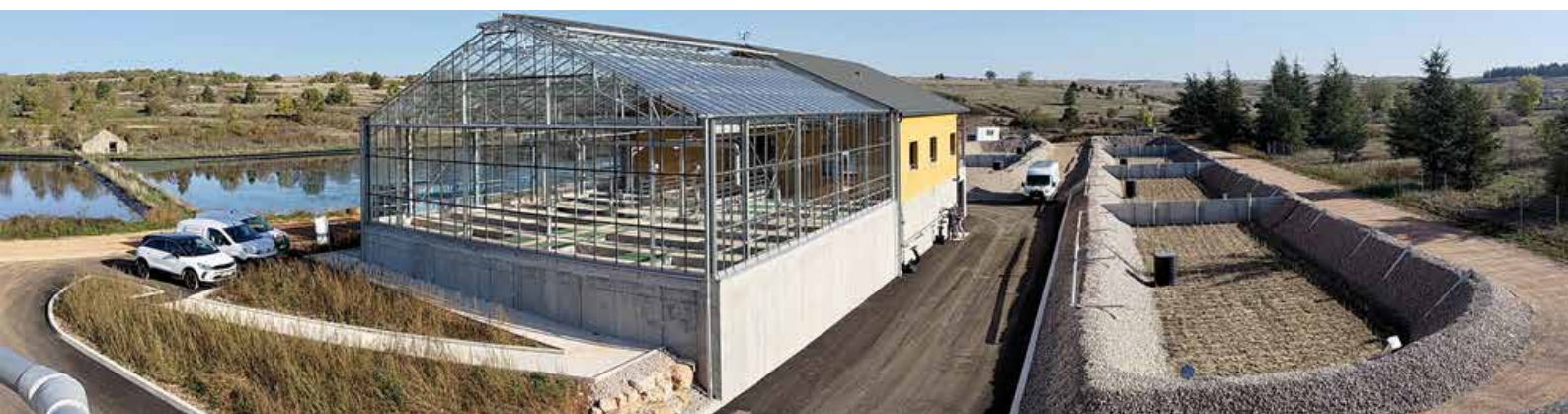
Station épuration de La Cavalerie
